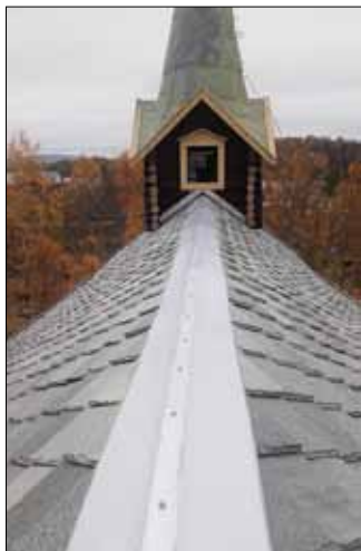
Jan Tollan og Arve Rye har skiftet mønpanner på Hodalen kirke. Samarbeid og forsiktighet er viktig når slike oppgaver løses, men bra blir det! Foto: Jan Tollan.
